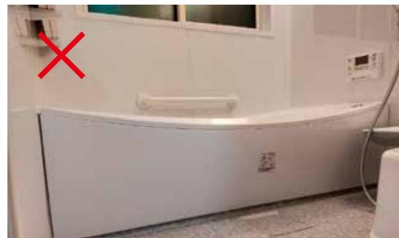
浴槽縁が中央に傾斜しており、挟み込みベースの水平が取れない浴槽は避けてください
